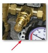
(2) Installation du CAR à l'intérieur de la vanne d'arrêt.
