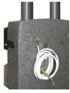
5. - Vorlauf-Fühlerkabel in die dazu bestimmte Öffnung in der Mitte der Isolierschale hineingeben, um es bei dem entsprechenden Vorlaufkugelhahn anschließen zu können.
