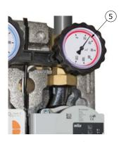
**6.** - Vorlaufkugelhahn (5) schließen (Thermometer mit rotem Ring)
