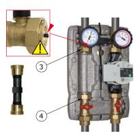
2. - Überwurfmuttern ③ und ④ aufschrauben und das Distanz- Rohr mit Übergängen abnehmen. Dies wird vereinfacht, wenn die hintere Isolierung abgenommen wird.
