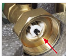
(4) Instalación de VNR dentro de la válvula de bola.
