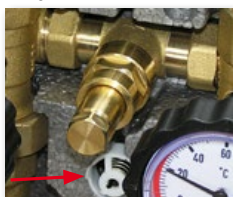
(3) Position des Rückschlagventils zum Zeitpunkt der Lieferung.
