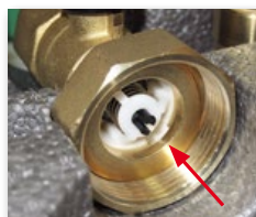
(4) Einbau des Rückschlagventils im Kugelhahn.
