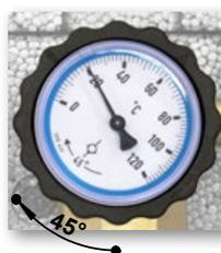
Pour vidanger le circuit, il faut exclure le clapet anti retour en tournant le volant avec thermomètre bleue de 45° dans le sens des aiguilles d'une montre, en partant de la position de complète ouverture (voir illustration à côté).
