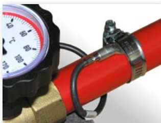
Abbildung 3: Verbindung des Rohranlegefühlers mit der Vorlaufleitung
