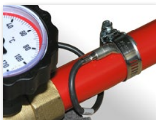
Figura 2: Collegamento della sonda a contatto sulla mandata
