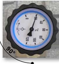
Bei Wartungsarbeiten das Kugelventil komplett schließen, indem das Stellrad um 90° im Uhrzeigersinn gedreht wird.
