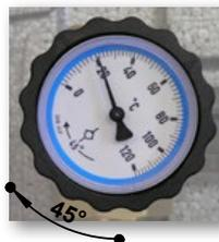
Pour le remplissage et le vidange du système il faut exclure le CAR en tournant le volant avec thermomètre bleu de 45° dans le sens des aiguilles d'une montre, à commencer par la position de complète ouverture (voir illustration à côté).
