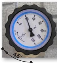
Per il riempimento e per lo svuotamento del circuito, escludere la VNR ruotando la manopola con termometro blu di 45° in senso orario, partendo dalla posizione di completa apertura (vedi figura a lato).
