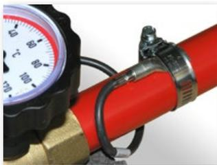
Figura 5: Conexión de la sonda de contacto en la vía de suministro
