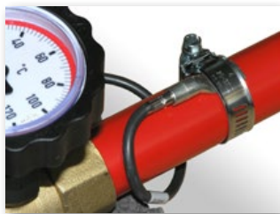
Figura 2: Collegamento della sonda a contatto sulla mandata
