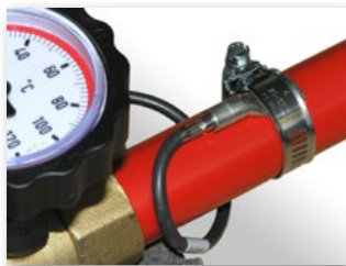
Illustration 2: Liaison de la sonde par contact au départ
