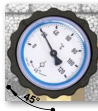
Para vaciar el circuito, apague el antretorno girando la perilla con un termómetro azul 45 ° en el sentido de las agujas del reloj, comenzando desde la posición completamente abierta (vea la figura a un lado).
