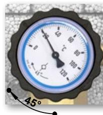
Für ein Entleeren des Solarfluids das Rückschlagventil isolieren, indem der Drehknopf mit blauem Thermometer 45° im Uhrzeigersinn gedreht wird, ausgehend von der vollständig geöffneten Position (siehe nebenstehendes Foto).
