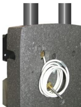
5. - Alloggiare il cavo della sonda di mandata nell'apposito passaggio al centro dell'isolamento, al fine di farlo fuoriuscire dal foro posteriore in corrispondenza della valvola a sfera a tre vie (ramo di mandata).
