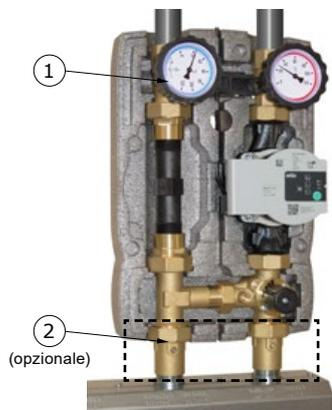
1. - Chiudere la valvola ① a monte del tronchetto sul ramo di ritorno. Intercettare il tratto a valle del tronchetto chiudendo la valvola ② se presente, in alternativa è necessario fermare l'impianto e svuotarlo parzialmente.
