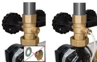
7. - Rimuovere il tappo e la guarnizione dalla terza via della valvola a sfera ed inserire nell'apposita sede la sonda di temperatura in mandata con il relativo premistoppa e or di tenuta (fare riferimento al manuale del produttore del contabilizzatore). L'operazione è più agevole allontanando la base dell'isolamento, se possibile.
