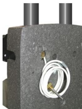
5. - Placez le câble du capteur de la voie de départ dans le passage spécial au centre de la coque isolante, pour le faire sortir par le trou derrière en correspondance de la vanne d'arrêt à trois voies (voie de départ).
